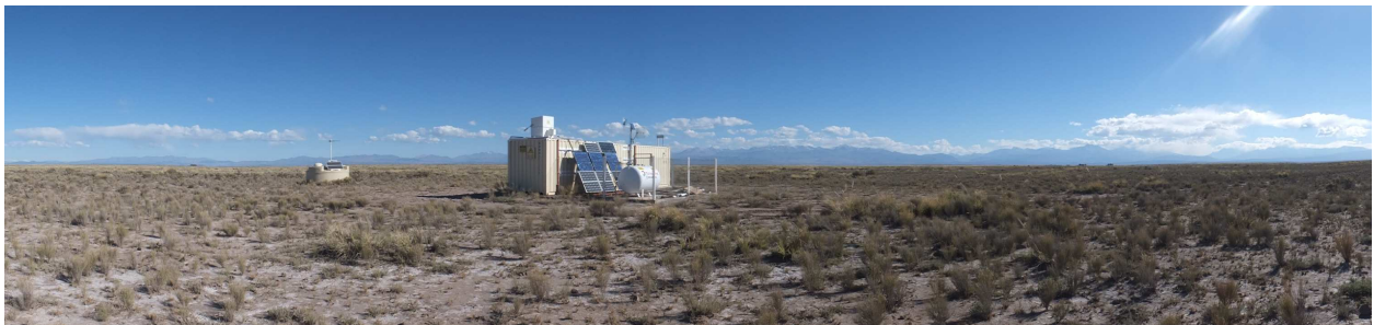
(d) The Completed CRLF
