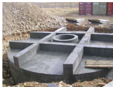
FIGURE 5.7 – Schéma d'une cuve Cherenkov du MD-KM2A (gauche) et photo du prototype (droite).
