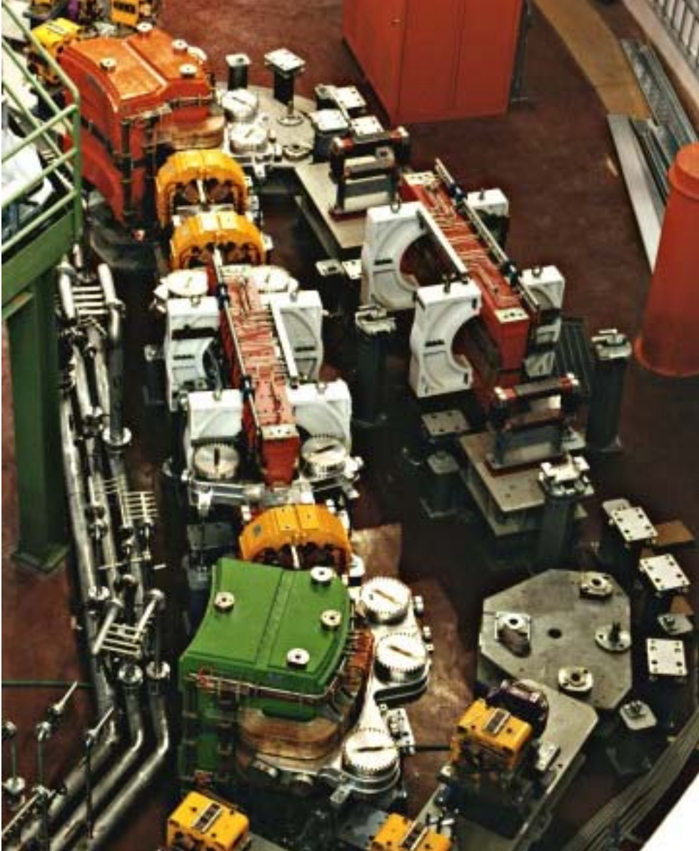
Figura 3.3: Un arco acromatico di una delle sezioni Short di Dafne durante la fase di installazione.
