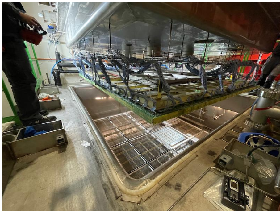
FIGURE 2.28 – Photo de l'installation d'un CRP dans la Cold-Box. On peut voir la cathode à l'intérieur avec un X-ARAPUCA (détecteur blanc sous la cathode) et, au-dessus, le toit de la Cold-Box et un CRP suspendu à celui-ci.
